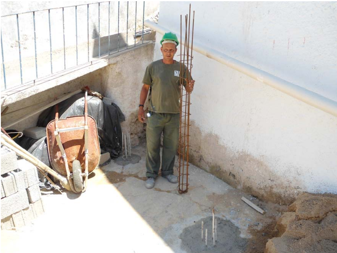
Reforço estrutural do muro existente.
