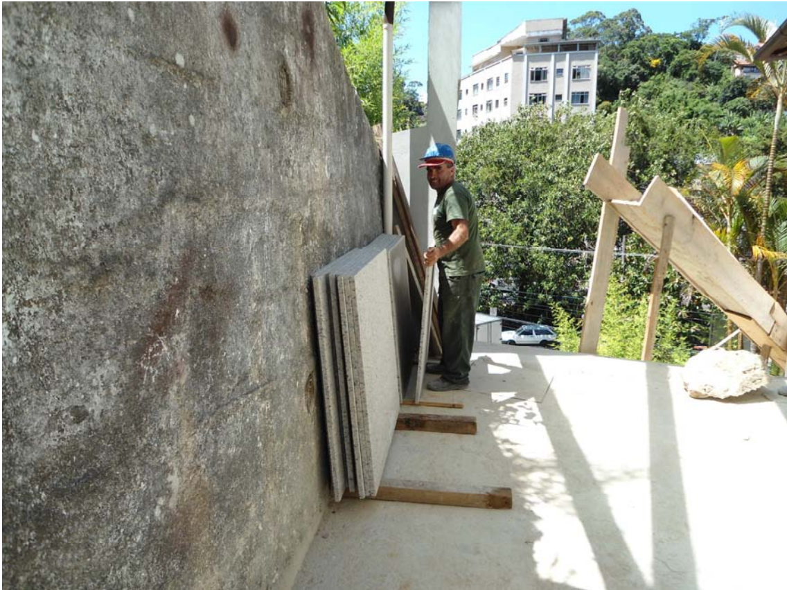
Granito para colocação no entorno da casa.
