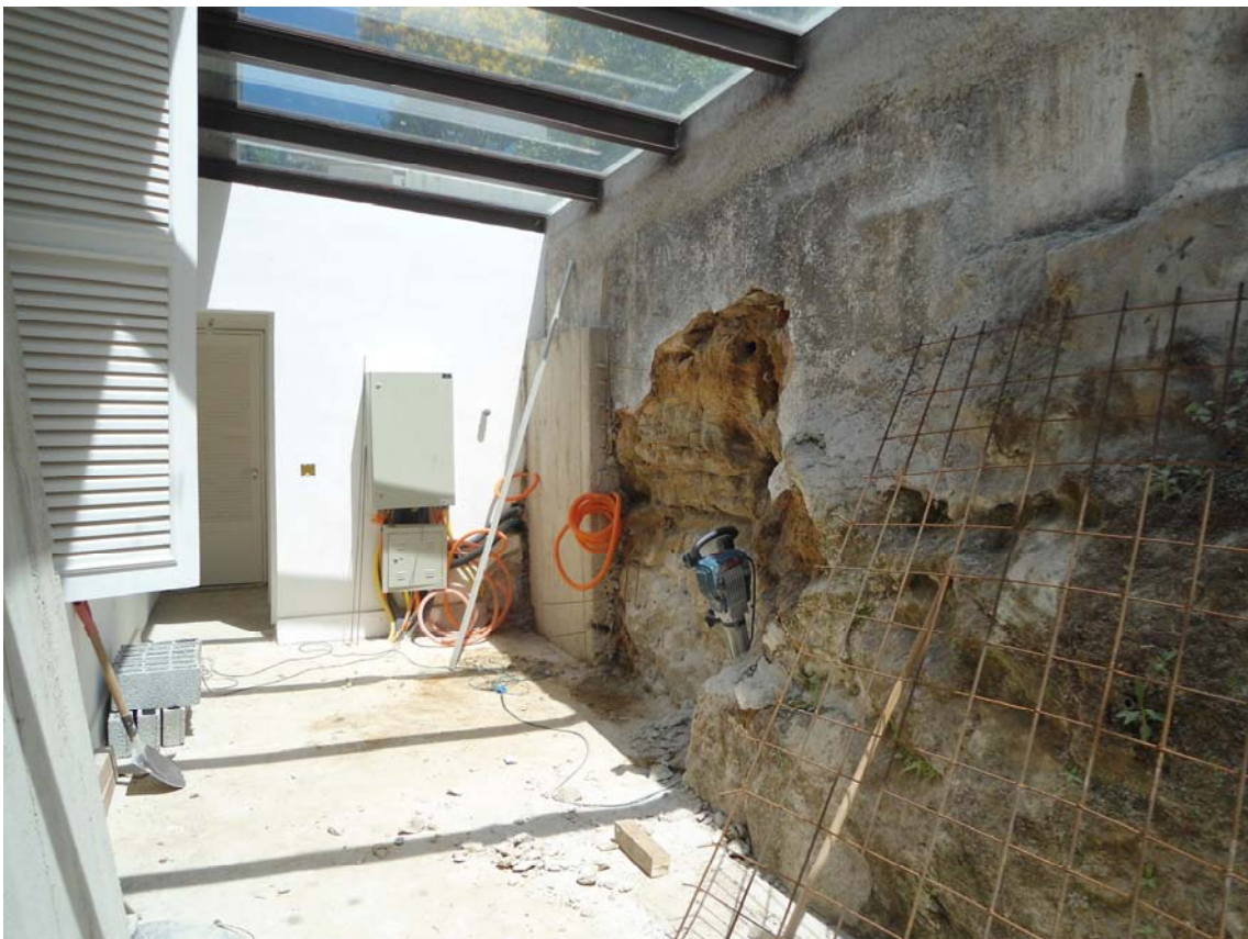
Demolição e execução de muro para ampliação da cafeteria.
