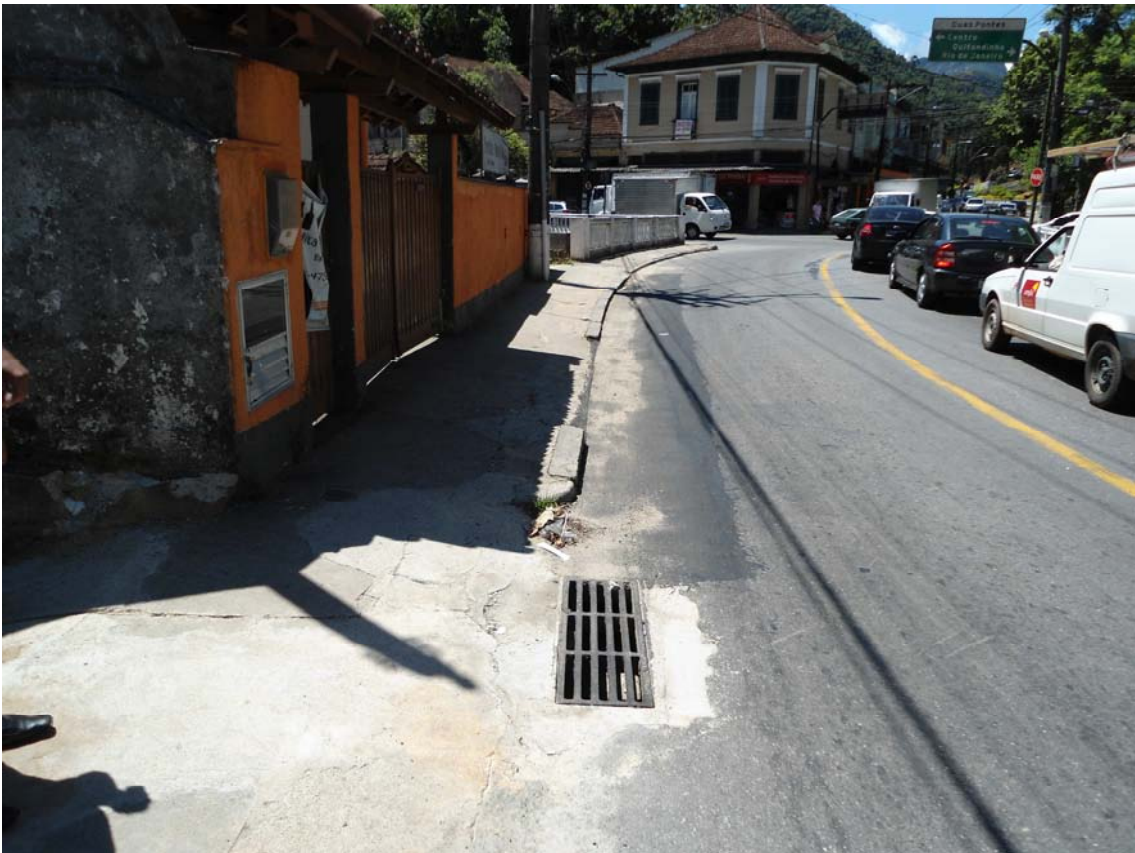
Interligação da nova rede de água pluvial da casa com o rio Quitandinha.
