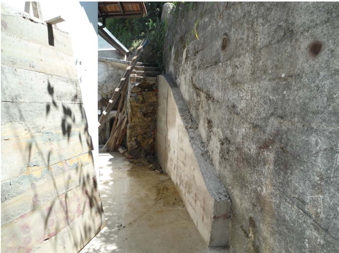
Execução de muro para retirada da antiga escada.
