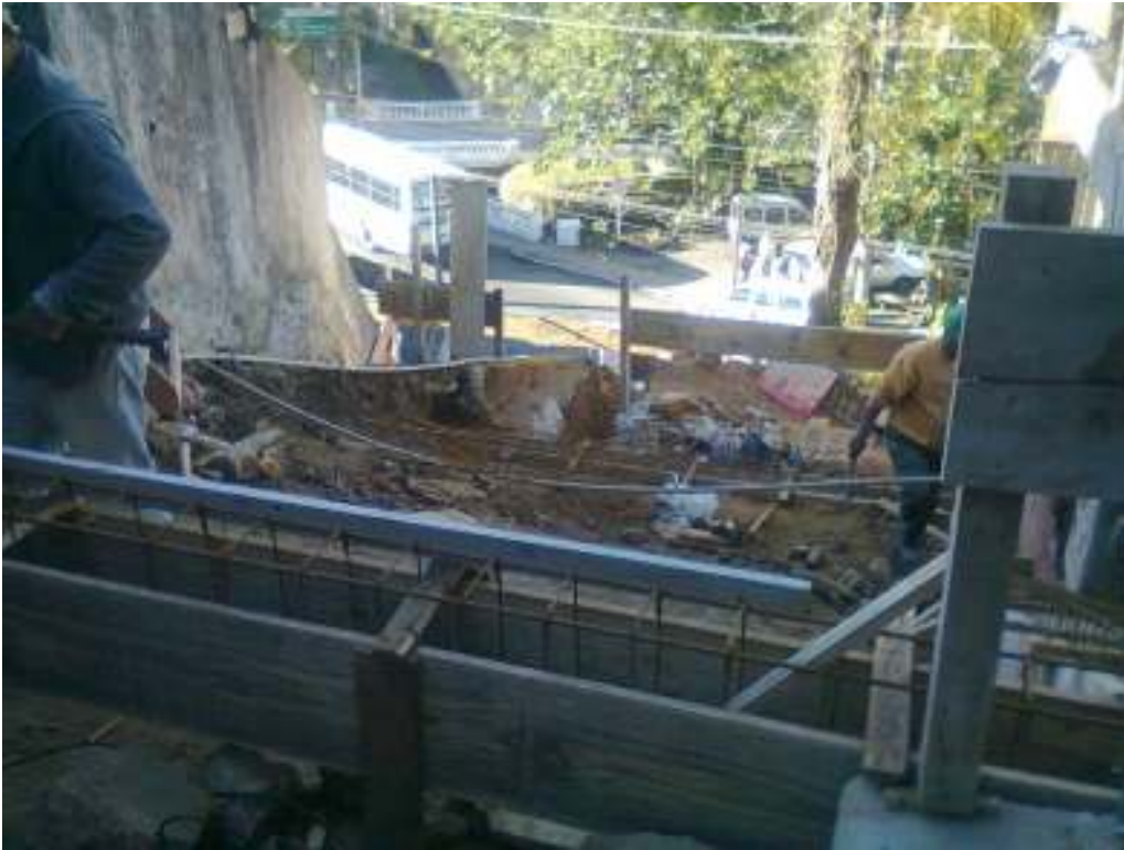
6) Vista da escada de acesso em execução
